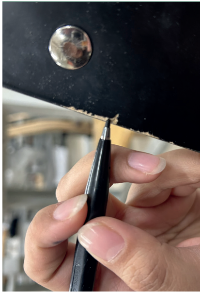
Kaschierung der Kratzer
