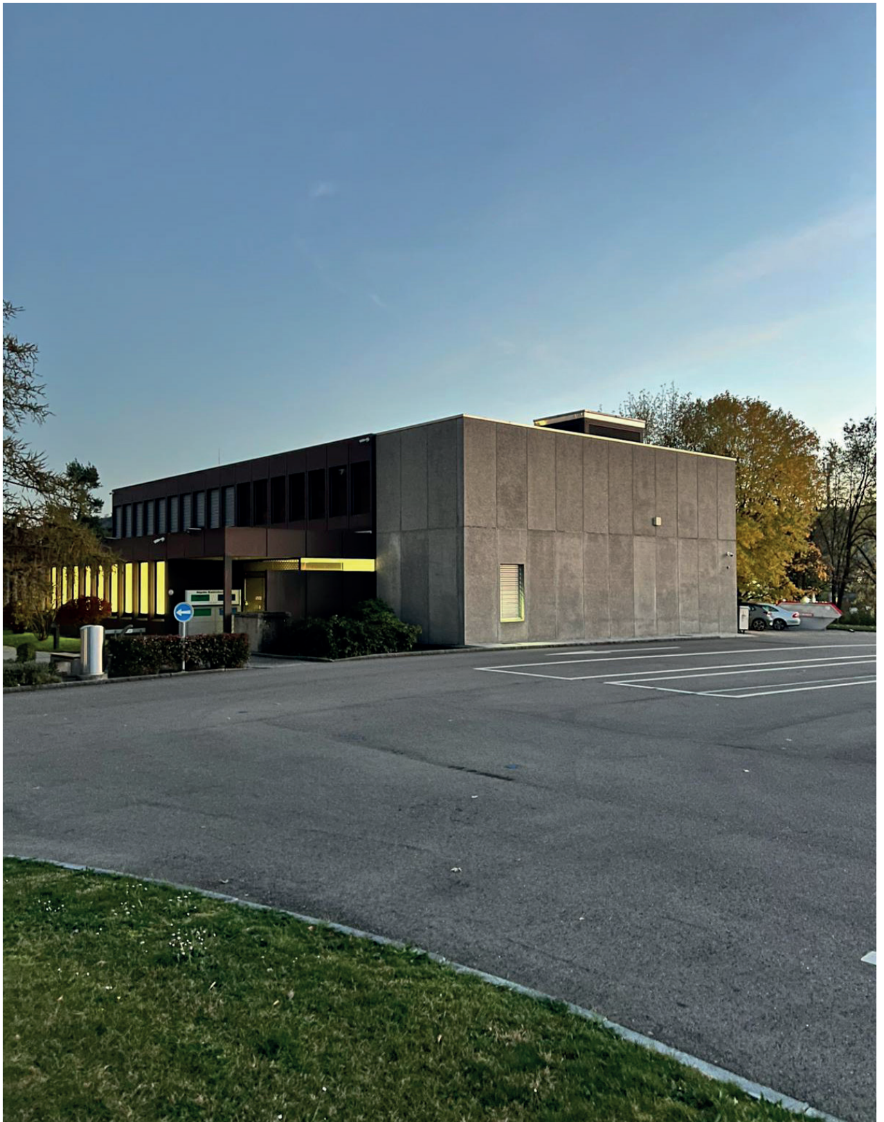
Fassadenverkleidung, Strassenverkehrsamt Winterthur, ca. 1970-1990
